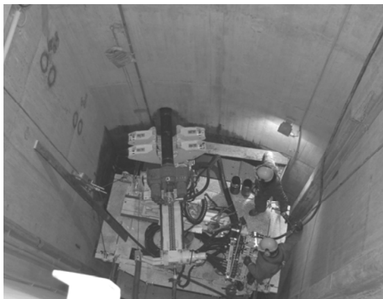
Figura 9 – Perforatrice all'opera all'interno del pozzo
