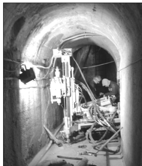
Figura 10. Sonda utilizzata per la perforazione dei dreni \Phi 200
